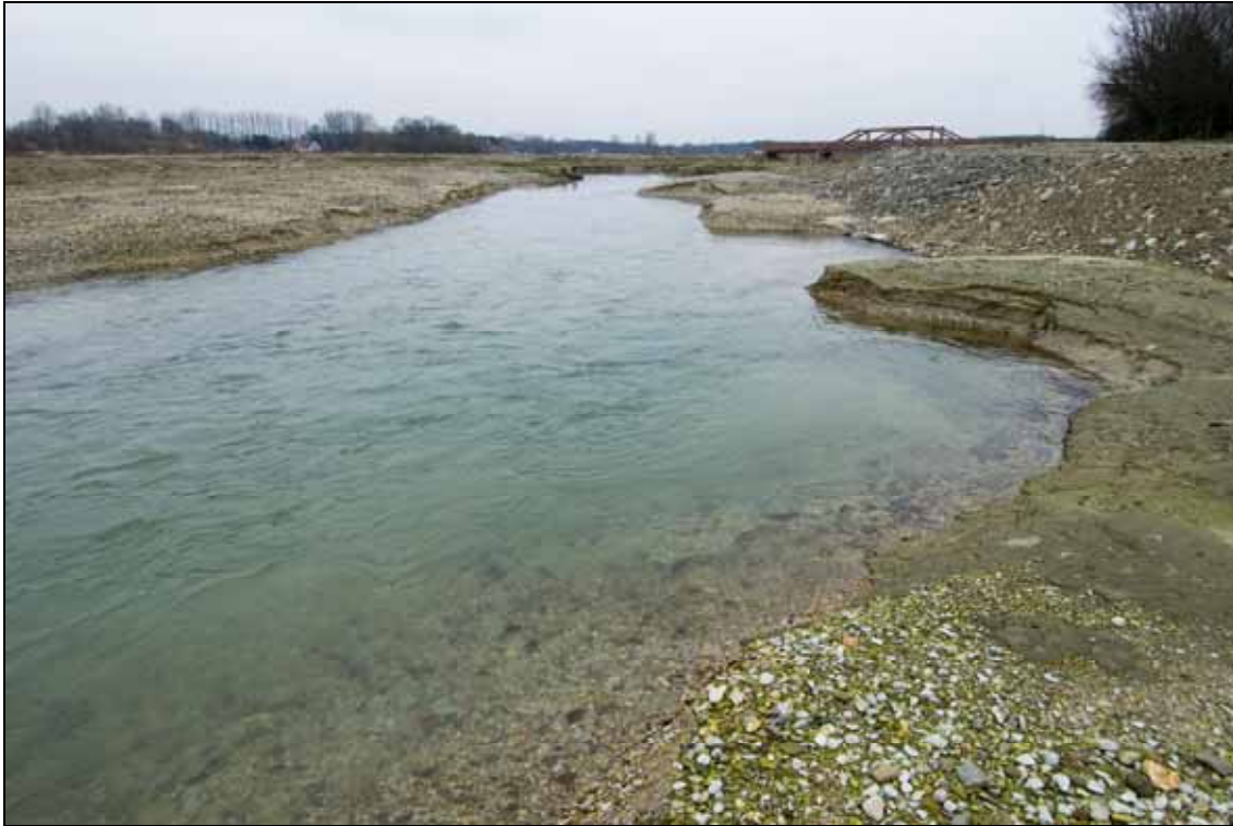
Abschnitt der Lippeseelumflut nach Herstellung eines Initialgerinnes durch Einspülung von Abraumkies (6 Wochen nach Abschluss der Einspülung)
